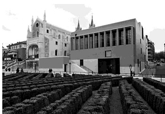
Рис.8. Музей Прадо, Мадрид, Испания, фасад нового здания.
