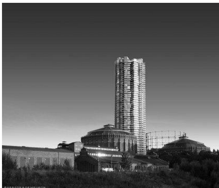
Рис. 2. Житловий комплекс, розміщений у колишньому газосховищі
