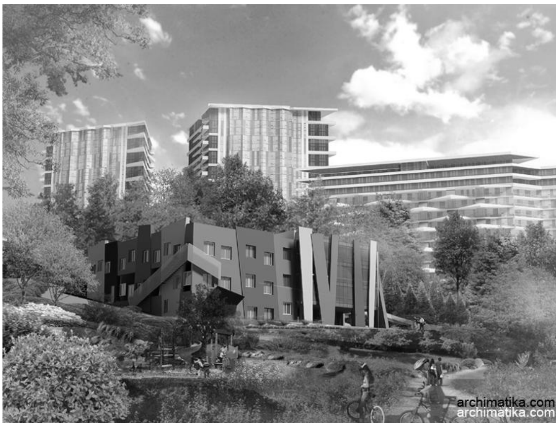
Дитячий садок в житловому комплексі «Green Terra». Київ. Арх. гр. «Архіматика».
