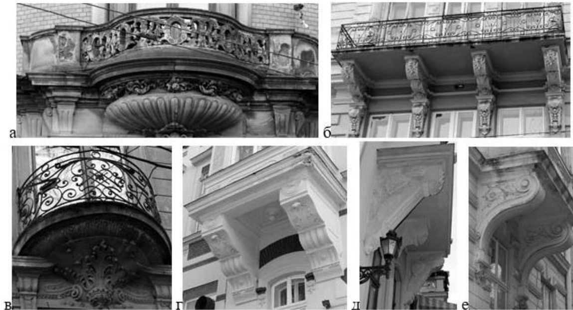
Рис. 4. Балкони за формою балконної плити та оздобленням огороження бувають: а) криволінійні, огороження муроване (пр. Свободи, 15); б) прямокутні, огороження оздоблене завитками, кругами, кронштейни – масками левів, картушами та ін. (пр. Шевченка, 34); в) півкруглі, огороження оздоблено завитками, квітами та ін. (вул. Ген. Чупринки, 7); г) кронштейни оздоблені акантовим листям та гутами (вул. Лук'яновича, 9-11); д) кронштейни оздоблені щитами та пальметами (пл. Маланюка, 7); е) кронштейни оздоблені волютами (вул. Рилєєва, 9).
