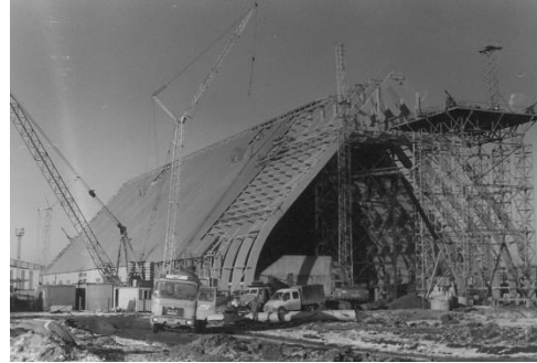
Рис. 22 - Каркас терміналу колійних луг прольотом 63м в м. Санкт-Петербург (Росія).
