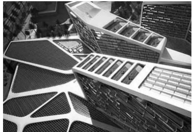
Рис. 4. Готель в Дубаї. Облицювання поверхонь сонячними батареями
