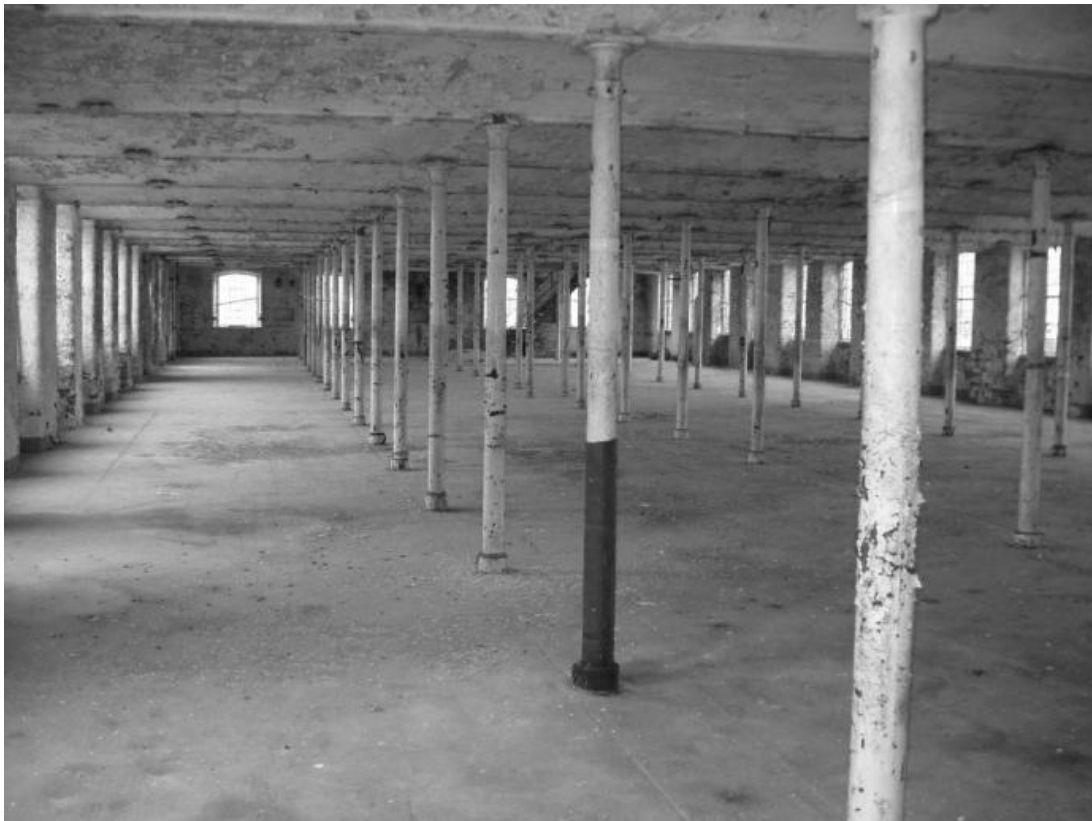
Рис. 3. Металевий каркас інтер'єру фабрики льону в Шрусбері [4].
