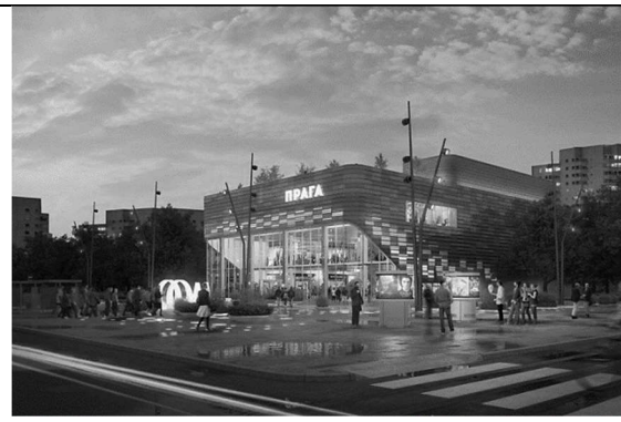
Рис.8. Загальний вигляд Кінотеатр «Прага» після реконструкції
