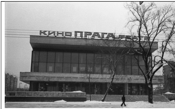
Рис.7. Загальний вигляд Кінотеатр «Прага» до реконструкції
