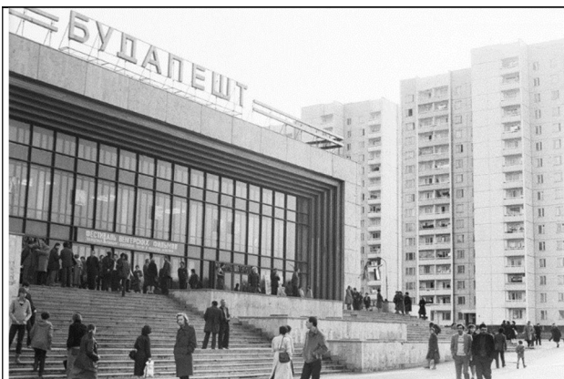
Рис.5. Загальний вигляд Кінотеатр «Будапешт» до реконструкції
