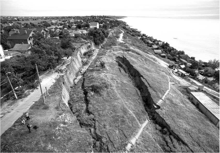
Рис. 1. Оползень в Фонтанке, фото – 30 августа 2017 г. [10]
