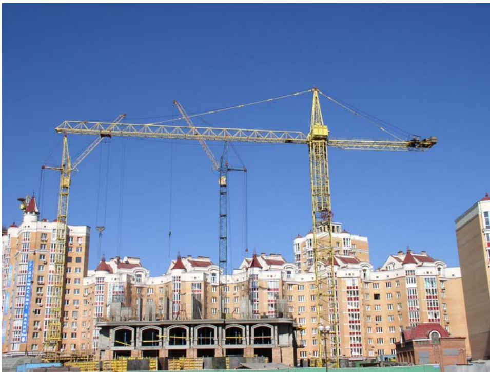
Рис. 1. Застосування баштових кранів УБК у будівництві м. Києва
