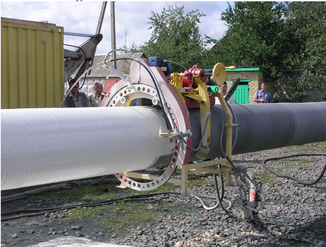
Рисунок 2. Нанесення поліуретанового покриття на фрагмент трубопроводу за допомогою агрегату МТУ 532.
