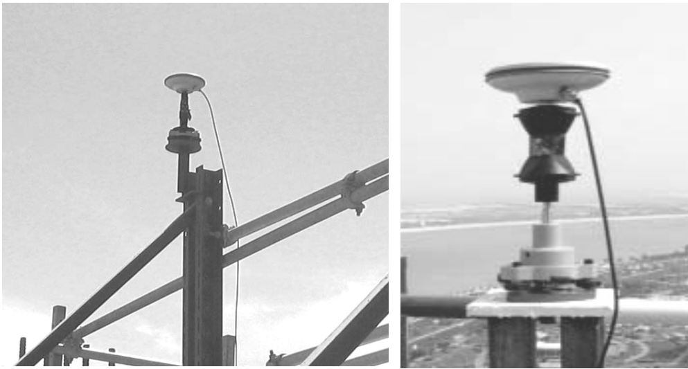
Рис. 4. Приймачі на монтажному горизонті з призми 360°
