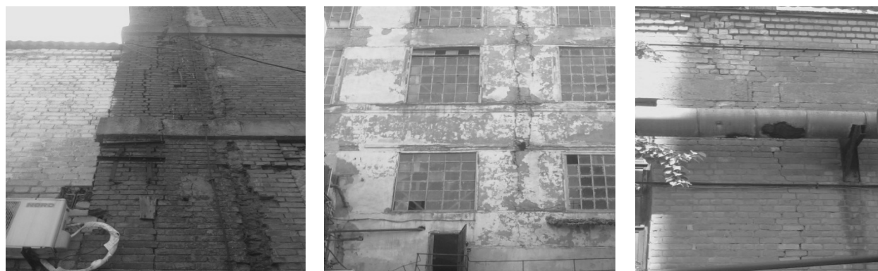
Рис. 3. Фотоматеріал про наявність рушення фундаменту та конструкцій споруди
