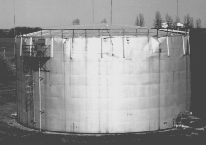
Рис. 1. Зовнішній вигляд резервуара ємністю 5000 м 3
