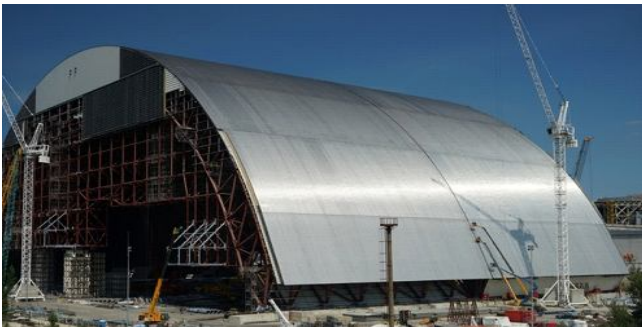
Рис. 5. НБК, смонтированный на монтажной площадке
