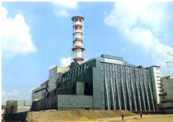
Рис. 1. Саркофаг ЧАЭС, сооруженный в 1986 году
