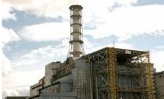
Рис. 2. Саркофаг ЧАЭС после усиления, выполненного в 2006 году
