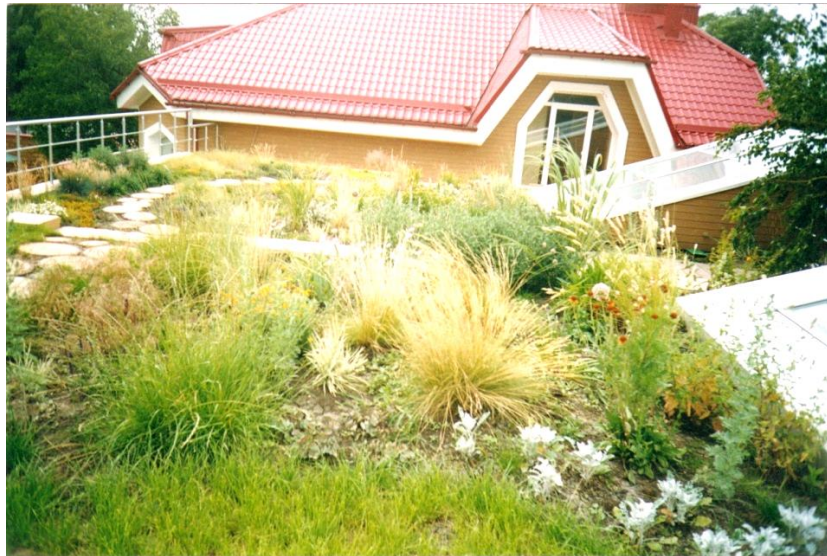
Рис. 2. Інтенсивна зелена покрівля зі степовим типом озеленення
