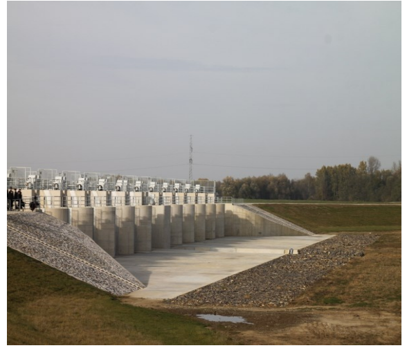
Фото 2. Водозабірні споруди найбільшого протипаводкового акумулюючого польдера «Самош-Красна», Угорщина, 2014
