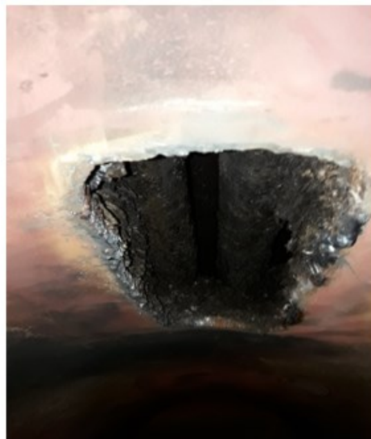
Рис. 5. Котел Riello RTQ-953 з вирізаною зоною перегріву
