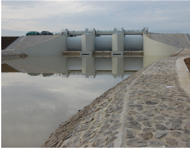
Фото 1. Водозабірні споруди протипаводкової акумулюючої ємкості «Циганд», Угорщина, 2008
