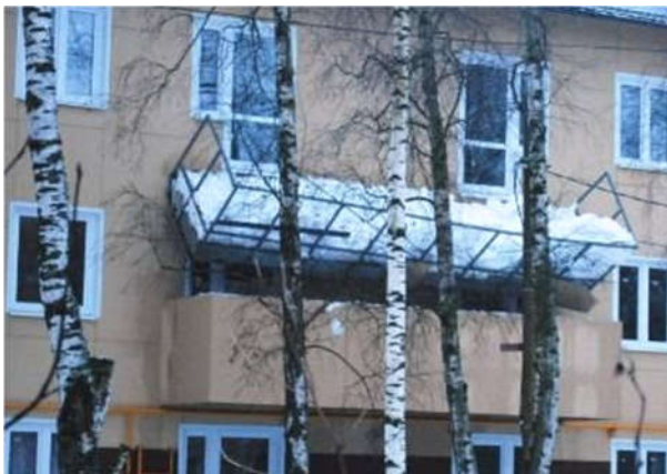
Рис.6. Руйнування балкону внаслідок збільшення снігового навантаження
