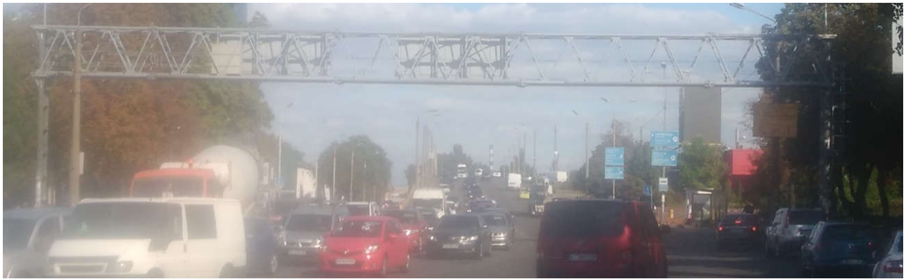
Рис.1 Сталева оцинкована рамна конструкція для автоматичних систем управління дорожнім рухом. Fig.1 Galvanized steel frame construction for automatic traffic control systems.
