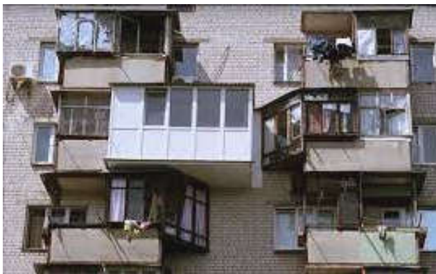
Рис.1. Добудовані балкони по фасаду житлового будинку
