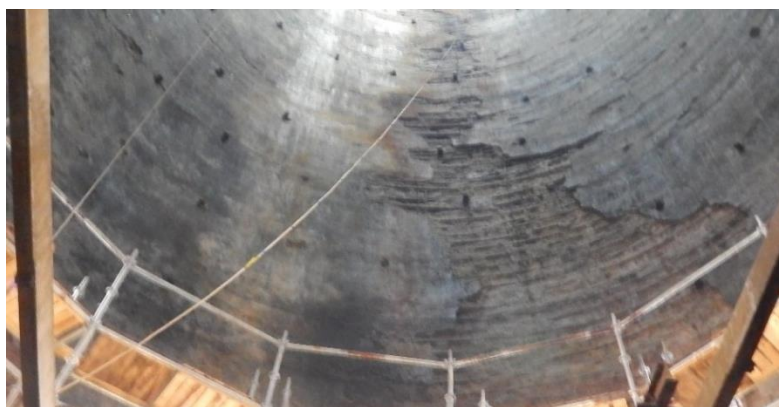
Рис. 2. Вид на деякі доступні ділянки внутрішньої поверхні стовбура башти Fig. 2. View of some accessible areas of the inner surface of the tower trunk
