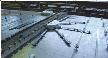
Рис. 2 – Застосування на практиці системи запобігання продавлювання.
