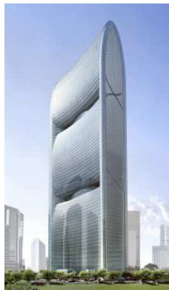
Рис. 4.14. Будівля Pearl River Tower (Перлинова річка) з вбудованими вітротурбинами
