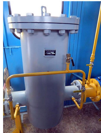
Рис. 10. Фільтр газовий волосяного типу ФГ: 1 – корпус; 2 – кришка; 3 – касета; 4 – прокладка; 5 – патрубок під КВП; 6 – диск
