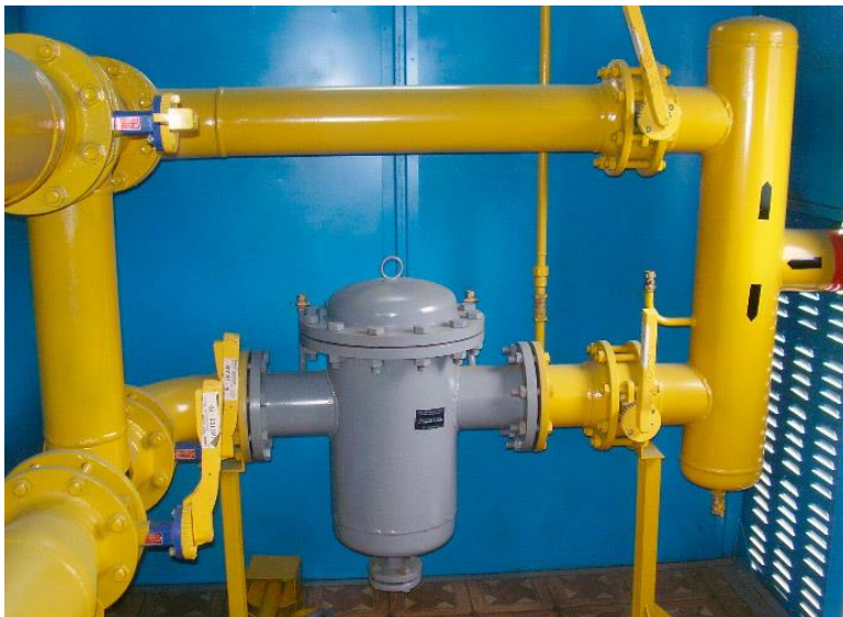
Рис. 11. Приклад розміщення фільтра газового ФГ
