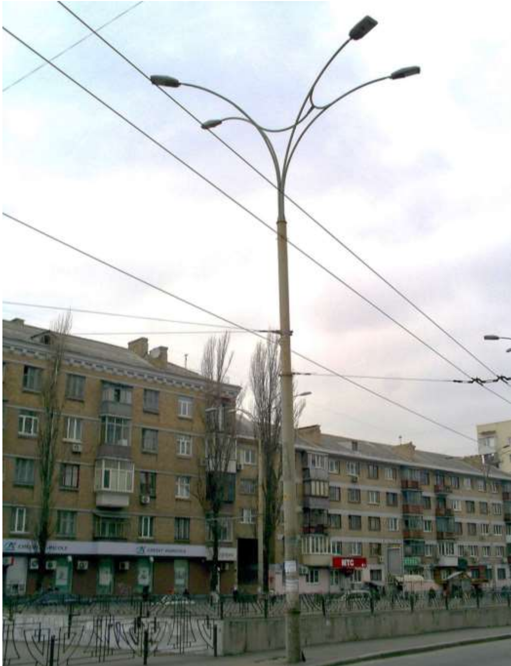
Рис. 5.6. Установка світильника на дорожньо-транспортному вузлі
