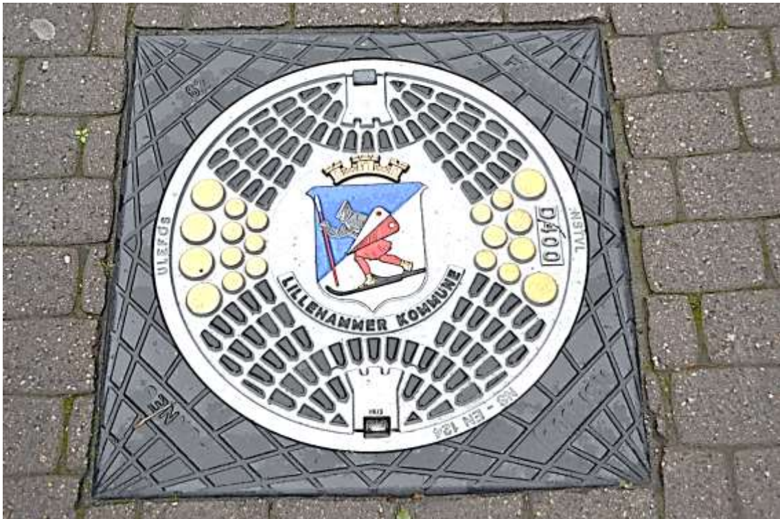
Рис.1.2. Каналізаційний колодязь
