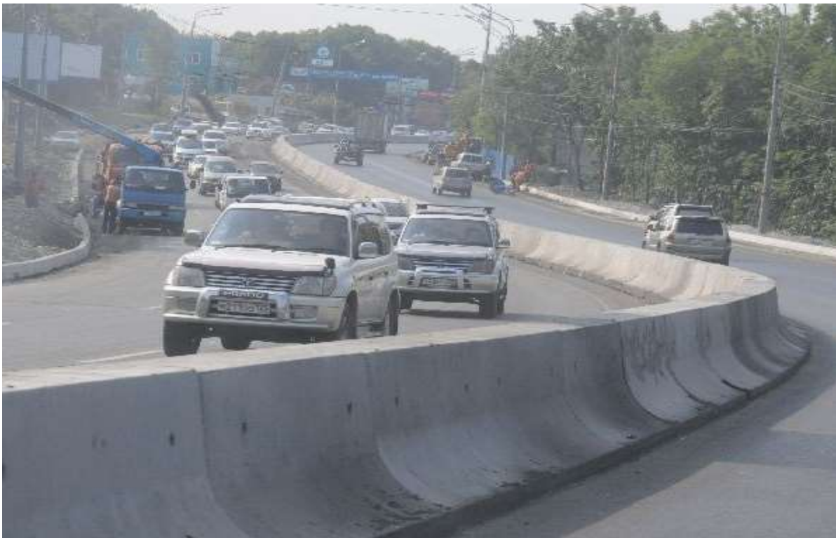
Рис. 8.7. Приклади високих бетонних бар'єрів: а – тип «Трієф»; б – тип «Нью-Джерсі»
