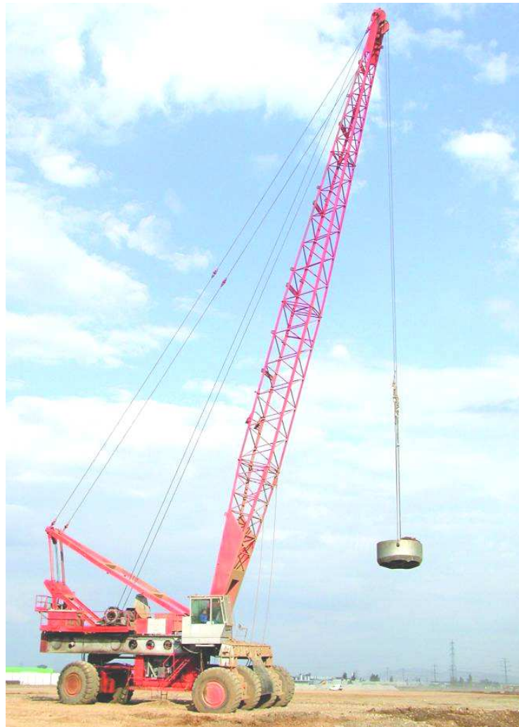
Рис. 4.21. Динамічне ущільнення ґрунту з використанням трамбівки 25 т з висоти 28 м
