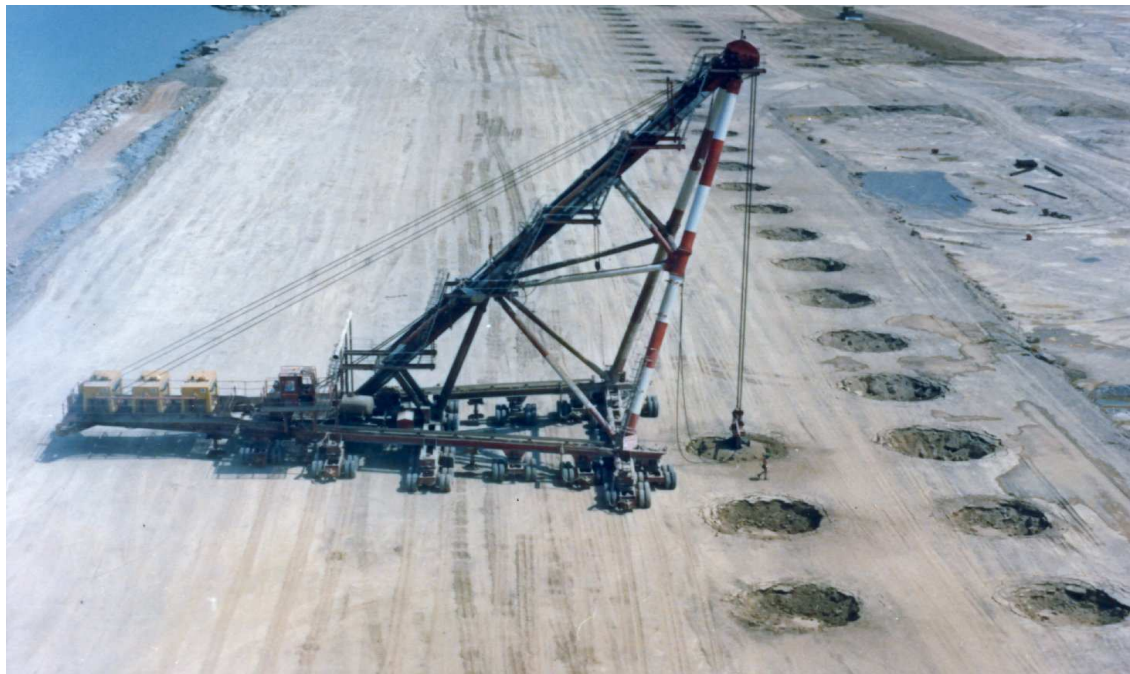
Рис. 4.22. Динамічне ущільнення ґрунту під час будівництва аеропорту в Ніцци (Франція) з використанням гіга-машини
