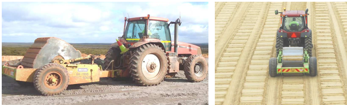
Рис. 4.20. Ущільнення ґрунту нециліндричним чотиригранним котком
