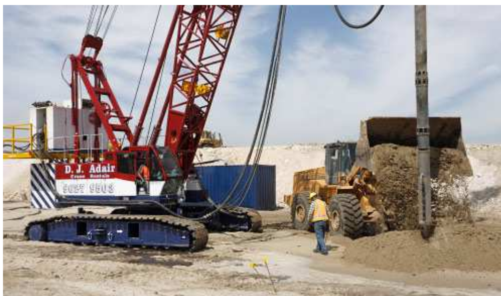
Рис. 3.17. Схема засипання кратера ґрунтом з повторним віброущільненням віброфлотатором
