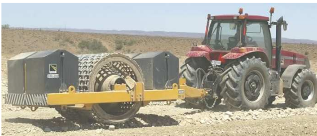
Рис. 4.6. Ущільнення ґрунту решічастим котком з баластом
