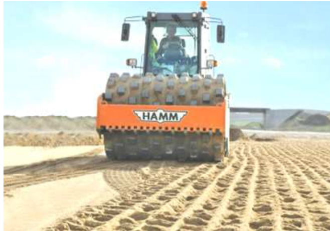
Рис. 4.11. Рух вібраційного котка з перекриттям слідів
