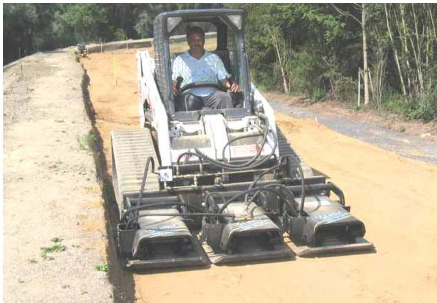
Рис. 4.16. Ущільнення насипного ґрунту вібротрамбувальними пластинами Stehr
