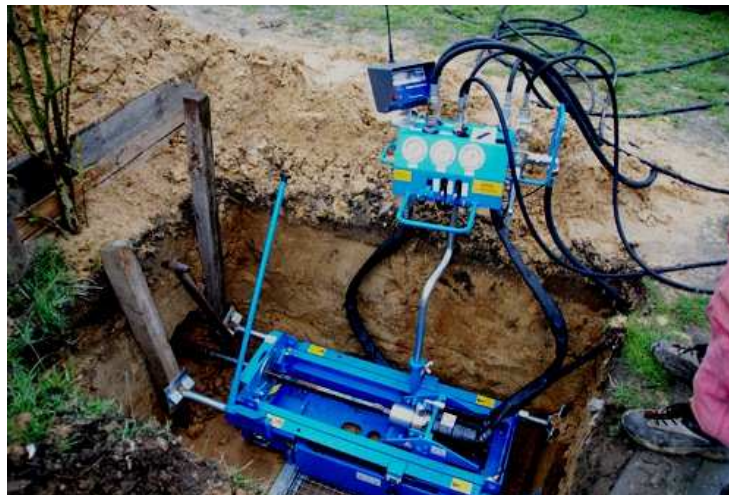
Рис. 47. Шахтова бурова установка: 1 – гідростанція; 2 – ємність для бурового розчину; 3 – пульт керування; 4 – водяний насос; 5 – лафет з гідроциліндрами і гідрообертачем; 6 – контейнер з ланками штанг (труб)
