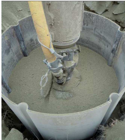
Рис. 33. Резервуар для шламу в буровому мультимолоті
