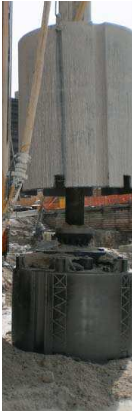
Рис. 35. Розвантаження бурового шламу з резервуару мультимолота
