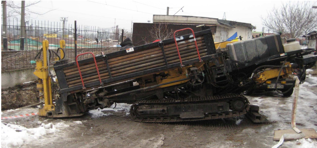
Рис. 52. Положення установки під час буріння
