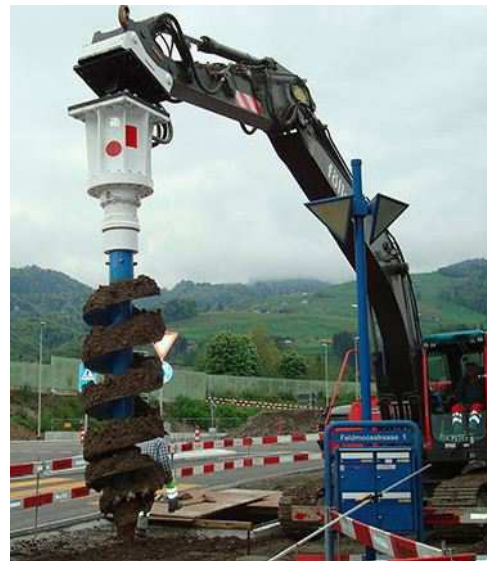
Рис. 13. Ямобур на самохідному шасі екскаватора
