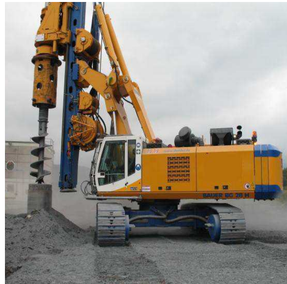
Рис. 41. Буріння з обсадною трубою
