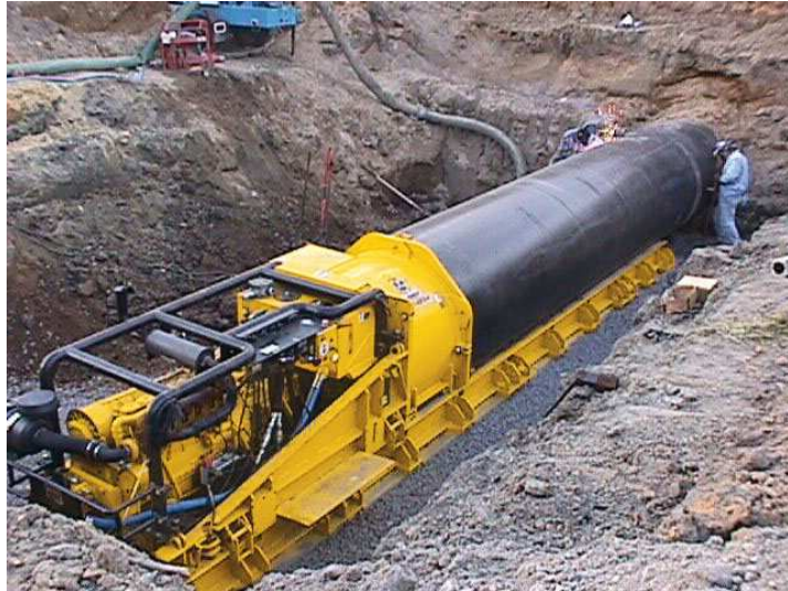
Рис. 46. Горизонтальне шнекове буріння з обсадною трубою
