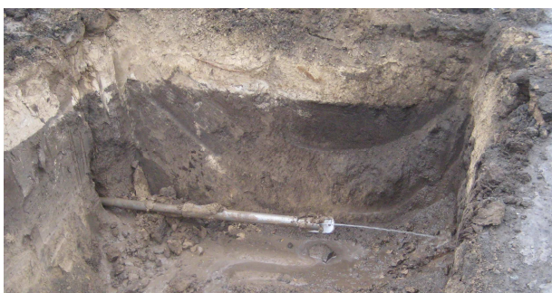
Рис. 56. Вихід бурової головки в напрямку
