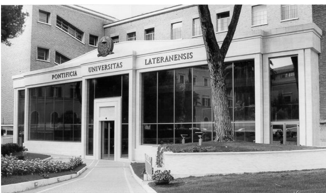
Рис. 2. Головний фасад з вхідним блоком
