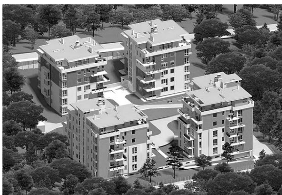
Рис. 5. ЖК «Оберіг», вул. Погулянка, 4а, 2012 р. [6].
