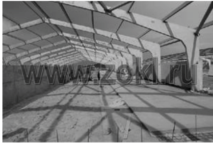
Рис. 1. Внутрішній вигляд каркасної будівлі
