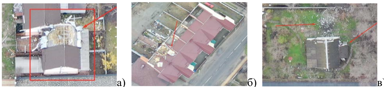
Рис.7. а) сильне руйнування; б) слабке руйнування; в) ймовірне руйнування.
