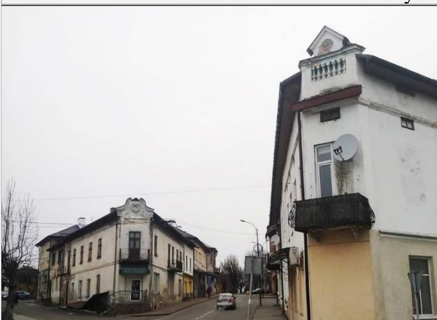
Рис. 4. м. Буськ Львівської обл. Фрагмент забудови вул. Паркової
