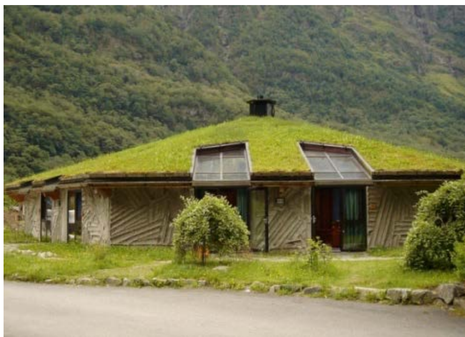
Рис. 3. Приклад будівлі з «зеленим дахом» [6]
