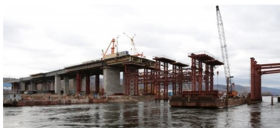
Рис. 6. Особливості надходження бетону до місця укладання поряд з берегом
