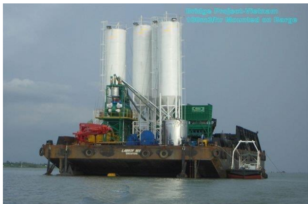
Рис. 7. Бетонозмішувальний завод фірми EUROTEC ASIA PACIFIC
