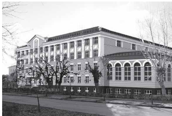
Реконструкція загальноосвітньої школи по вул. Іоанна Павла II в Києві. Жданюк В.І., Куцевич В.В., Губов Б.М., КиївЗНДІЕП.
