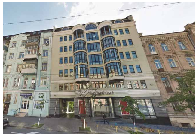
Офісний комплекс по вул. Саксаганського, 105 в Києві. В.І. Єжов, Д.В. Єжов.
