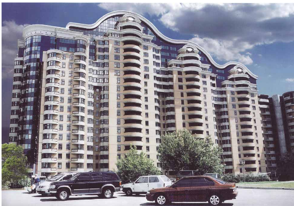
Житловий комплекс по вул. Старонаводницька, 13 в м. Києві. 1999-2002 рр.
