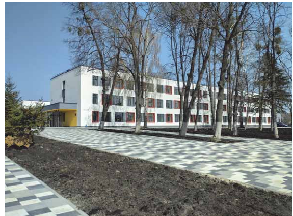
Реконструкція та будівництво Бородянського ліцею №1 Бородянської селищної ради в смт. Бородянці, Київської обл.
