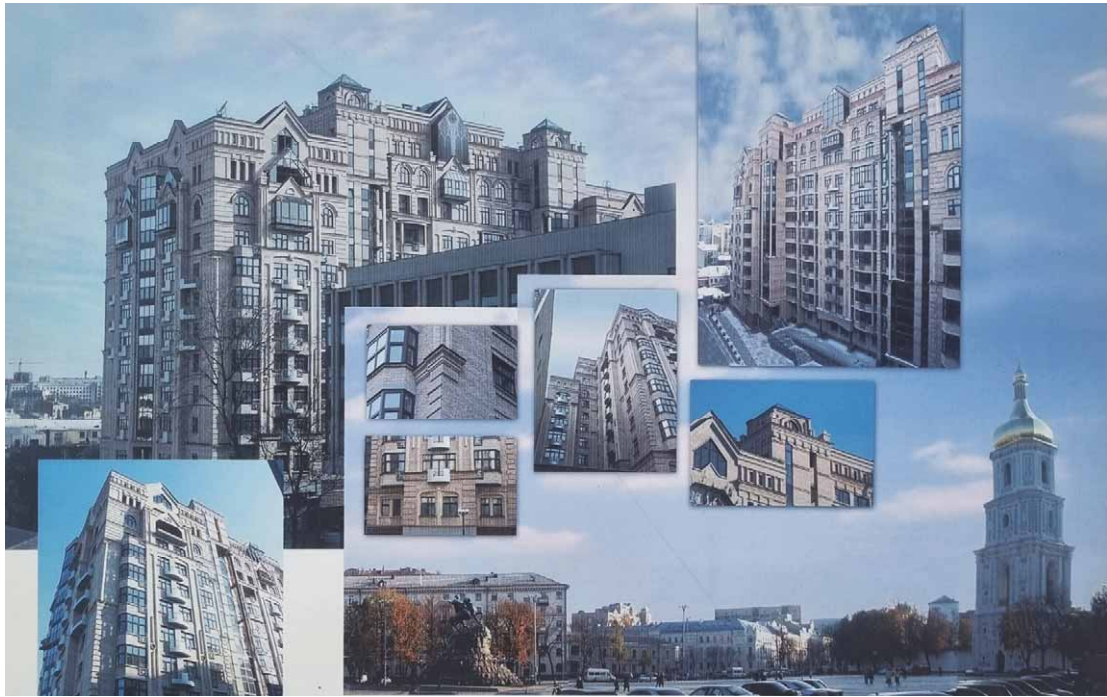
Житловий комплекс по вул. Паторжинського, 14 в м. Києві
