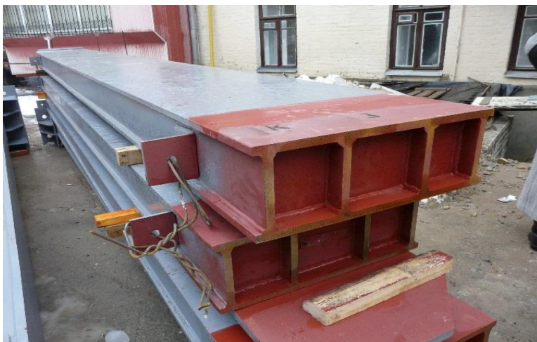
Фото 2. Зварні колони каркасу.
