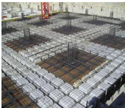
Рис. 2. Плита з порожнинами в обох напрямках
