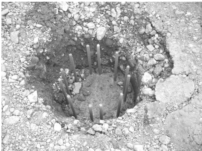
Рис.3. Зовнішній вигляд свердловини, щойно заповненої бетоном
