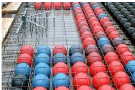
Рис. 3. Перекриття з кульковими вкладишами системи "Bubble Desk"
