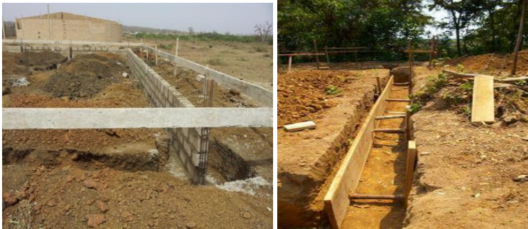
Рис.5. Влаштування опалубки при зведенні стрічкових фундаментів
