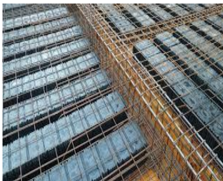
Рис. 1. Плита з порожнинами в одному напрямку
