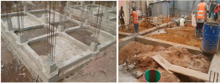
Рис.4. Конструктивне рішення стрічкових фундаментів
