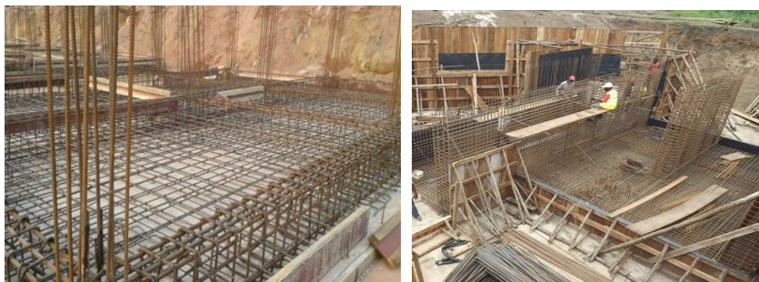
Рис.3. Армування плитній фундаменти
