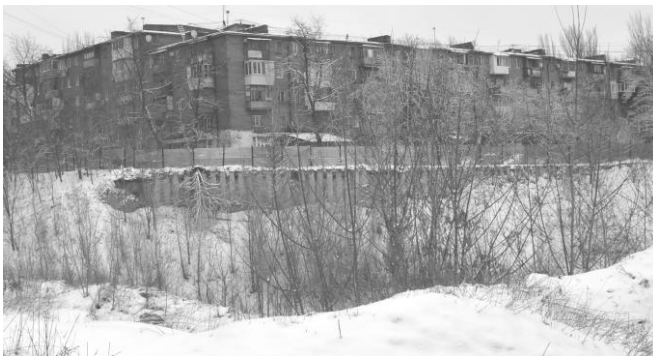
Рис. 5. Додаткова шпунтова стінка (вигляд станом на січень 2018 року)
