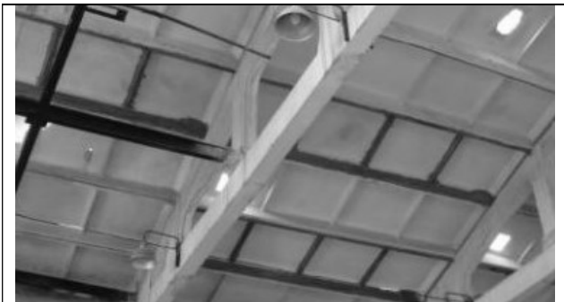
Рис.7. Підсилення поздовжніх і поперечних ребер залізобетонних плит покриття зовнішнім армуванням композитним матеріалом на основі вуглецевих волокон.
