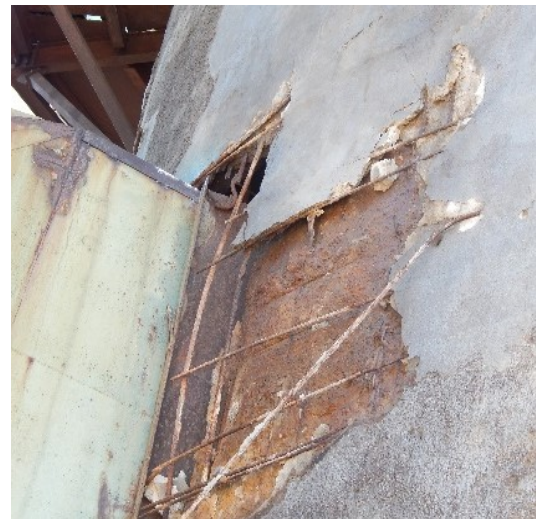
Рис. 5. Наскрізне руйнування стовбура біля коробки, відсутність шару бетону за арматуру зовнішньої сітки
