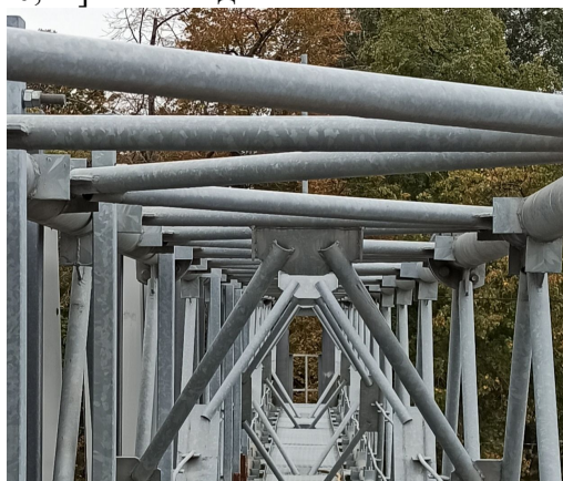
Рис. 1. Сталеві оцинковані конструкції з трубчатих елементів для автоматичних систем управління дорожнім рухом.
