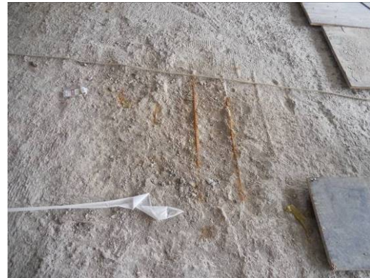
Рис.4. Руйнування захисного шару бетону, корозія арматури на верхній грані плити перекриття Fig. 4. Damage of the concrete cover and reinforcement corrosion on the upper side of the 8 th -floor slab
