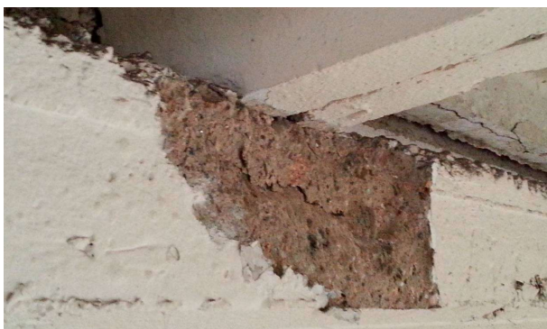
Рис.8. Відкол бетону в полиці залізобетонної балки в місці обпирання на балку поздовжнього ребра плити покриття.
