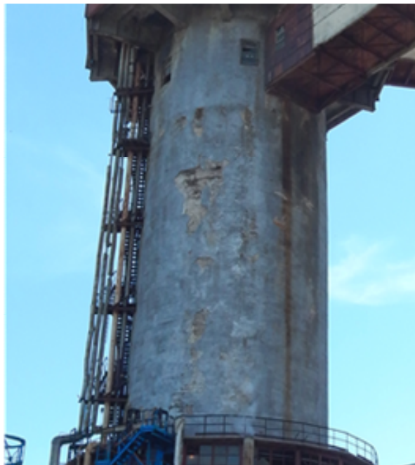
Рис. 1. Стовбур башти зі значними площами ділянок поверхневої деградації бетону Fig. 1. The tower trunk with large areas of concrete surface degradation
