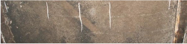
Рис. 3. Розташування робочої арматури в плиті (позначено крейдою)
