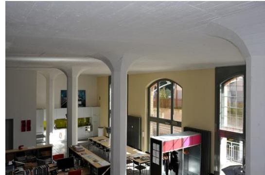
Рис.4. Складська будівля з безбалковими перекриттями, м. Цюріх, Швейцарія, інж. Роберт Майяр, 1910 р.:
