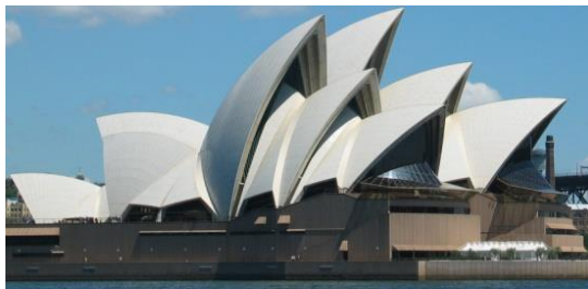
Рис. 13. Залізобетонні оболонки складної форми: а – термінал аеропорту ім. Кеннеді, м. Нью-Йорк, США, 1956...1962 рр.. б – оперний театр, м. Сідней, Австралія, арх. Й. Утзон, 1959...1973 рр.
