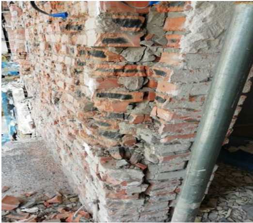
Рис. 10. Розшарування простінка по всій площі внаслідок удару мінометною міною по балкону
