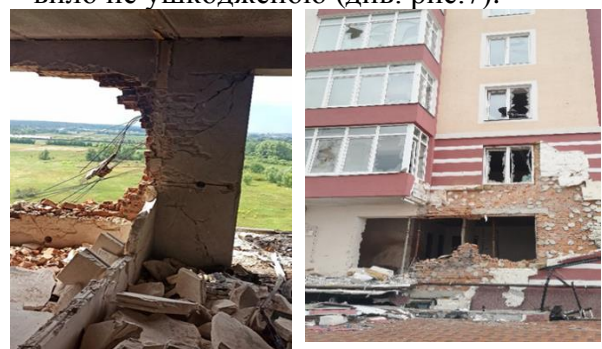
Рис. 7. Руйнування 60% та 100 % цегляного перестінка.
