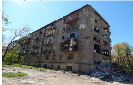
Рис.6. Руйнування торцевої стіни будинку внаслідок вибуху ракети
