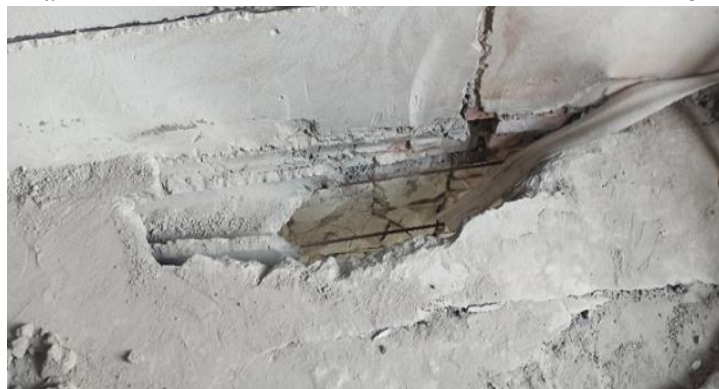
Рис 9. Наслідки потрапляння боєприпасів по будинку в Гостомелі: а - руйнування балконної плити; б - зруновані стіни і перегородки; в - руйнація плити перекриття.
