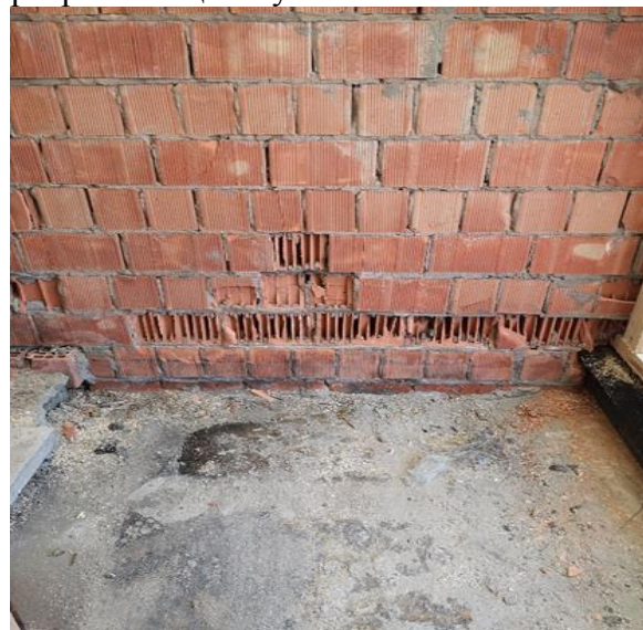
Рис. 12. Характер пошкодження порожнистих керамоблоків від високої температури.
