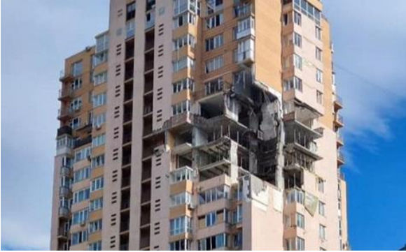
Рис. 2. Каркасний будинок в Києві, куди потрапила ракета
