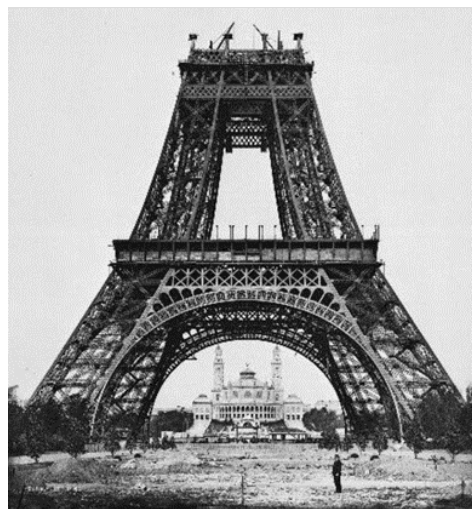
Рис.3. Ейфелева вежа 20 березня 1888 року після зведення першого рівня (а) [2] та 21 серпня 1888 року після зведення другого рівня (б) [2]
