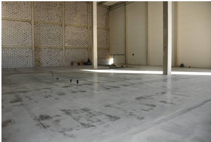
Рис.4. Підлога влаштована з використанням фібробетону.
