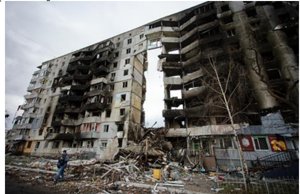
Рис. 4. Будинок у м. Бородянка з порушенням цілісності секції
