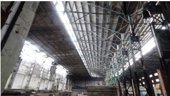
Рис. 1. Каркасна будівля з прогонами на покрівлі якої планується збільшення навантаження шляхом встановлення Сонячної електричної станції.
