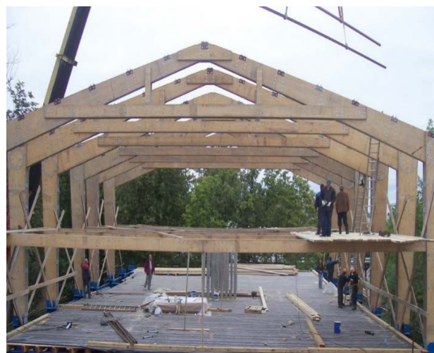
Рис.10. Надбудова з рам із клеєної деревини. Фото з власного архіву.
