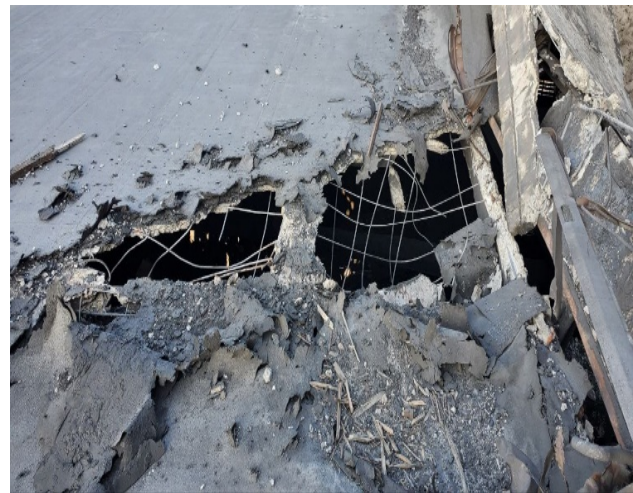
Рис. 1. Зруйновані плити покриття внаслідок артилерійського обстрілу. Фото 1. Д. Журавський, 2022 Fig. 1. Destroyed cover slabs as a result of artillery fire. Photos 1 by D. Zhuravskiy, 2022
