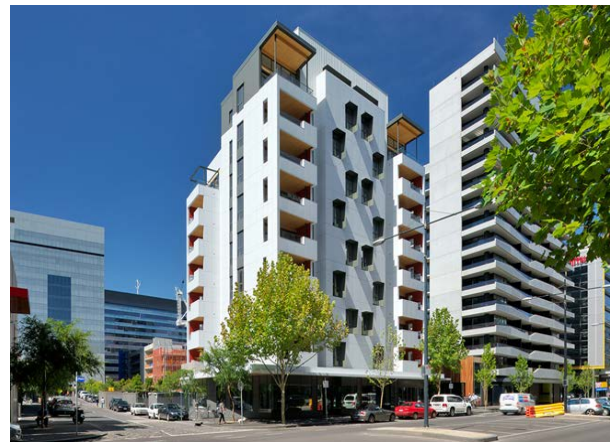
Рис.5. Десяти поверховий будинок Forte Building в Мельбурні,. [12]
