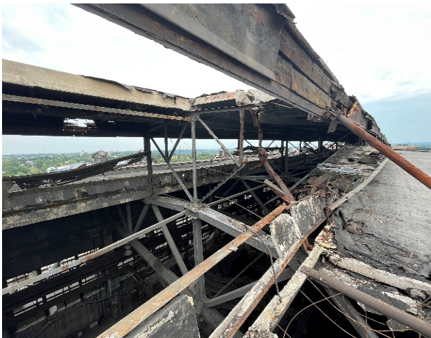
Рис. 1. Зруйновані плити покриття внаслідок артилерійського обстрілу. Фото 1. Д. Журавський, 2022 Fig. 1. Destroyed cover slabs as a result of artillery fire. Photos 1 by D. Zhuravskiy, 2022
