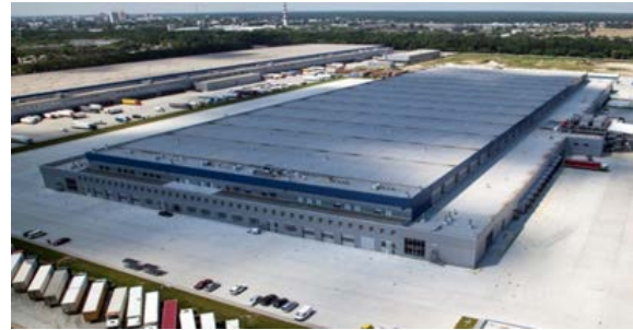
Рис. 1. Загальний вигляд об'єкту до обстрілу Fig. 1. General view of the object before the shelling
