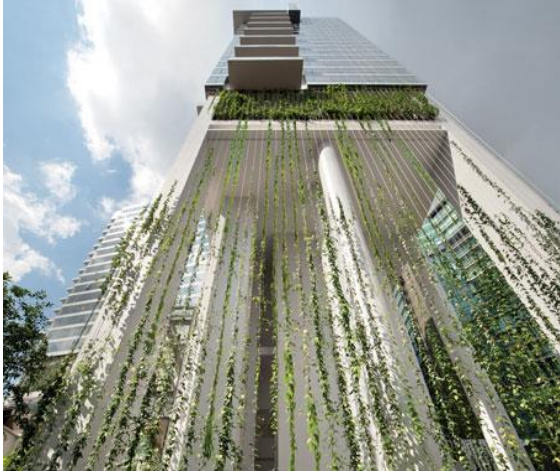
Рис.2. Helios Residences в Сінгапурі, влаштування системи з тросів та канатів
