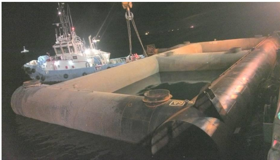
Рис.4. Відрізаний понтон після підймання на поверхню
