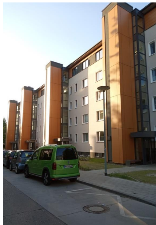
Ліфт панельного будинку після реконструкції м. Росток, Німеччина
