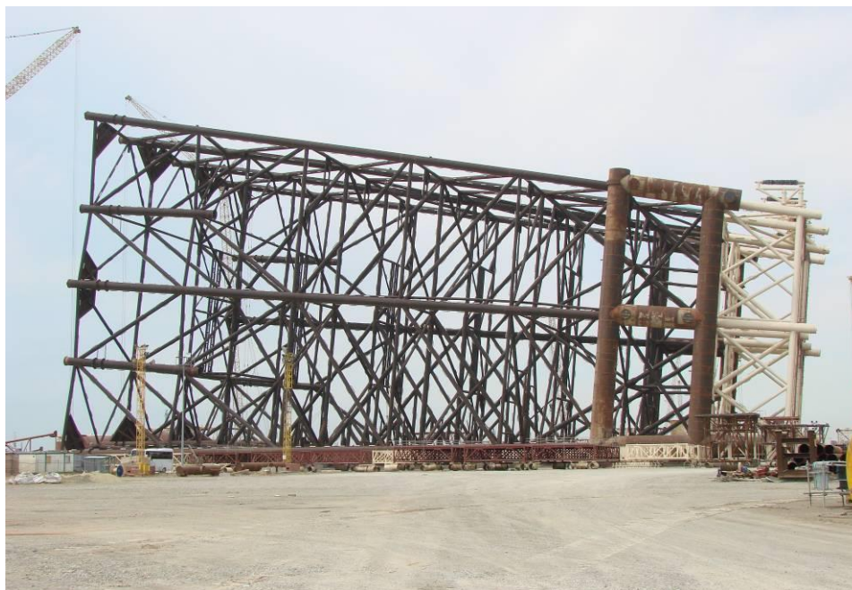
Рис.1. Основа платформи МСП-7 з привареними понтонами
