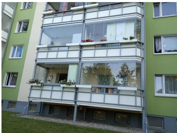
Централізоване засклення балконів після реконструкції в м. Росток, Німеччина
