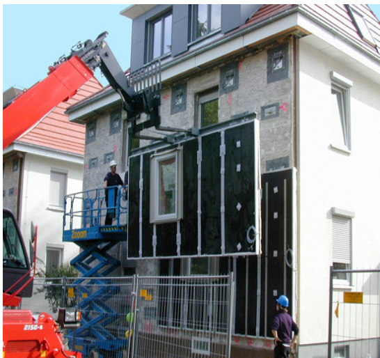
Рис. 5. Утеплення фасадів житлового будинку вакуумними панелями
