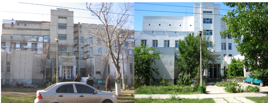
Рис. 2. Санація будівлі, вигляд до і після.
