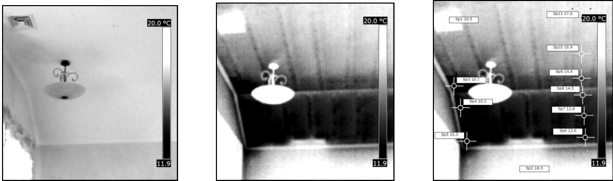
Рис.8. Тепловізійна візуалізація тепловтрат через дах
