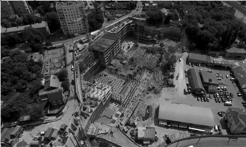
Фото 1. Інженерна-підготовка територій для будівництва багатоповерхового житлового комплексу з підземним паркінгом в Печерському районі м. Києва
