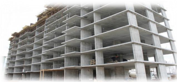
Рисунок 1 – Фотографічне зображення залізобетонного монолітного каркасу будівлі
