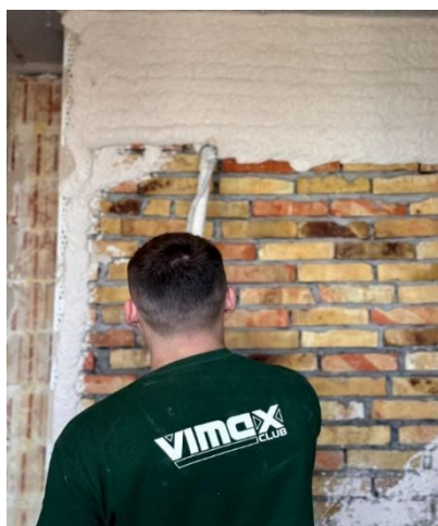
Рис. 1. Процес нанесення вапняної штукатурки механізованим способом
