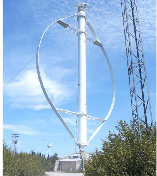
Рис. 5. Найбільший VAWT з ротором Дар'є, центр інтерпретації енергії вітру, Квебек, США
