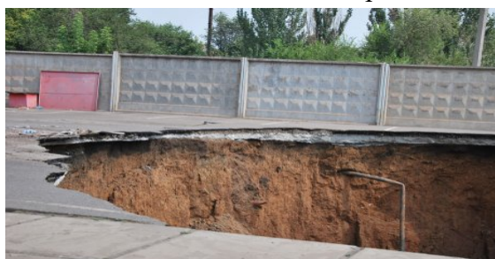
Рис. 3. Обвалення земної поверхні з утворенням воронки на вулиці Урицького, 5 (17.08.2010 р.)
