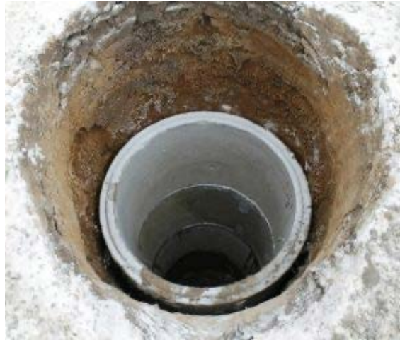
Рис. 1. Опускний колодезь
