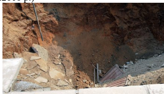
Рис. 3. Обвалення земної поверхні з утворенням воронки на вулиці Урицького, 5 (17.08.2010 р.)
