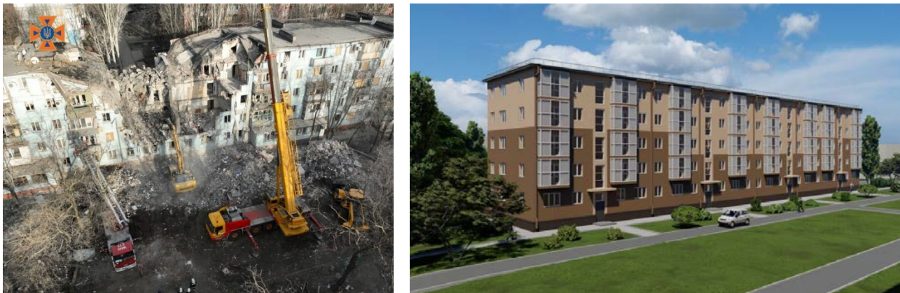
Рис. 2. Приклад відновлення пошкоджених російськими ракетами будинків у Запоріжжі, було-стало [11]: проєкт відбудови будинку в точності відповідає визначеному урядом принципу відновлення України – «краще, ніж було»; тут передбачено не тільки відновлення зруйнованих після влучання ракети конструкцій, а максимальне осучаснення з комплексною енергоефективною модернізацією
