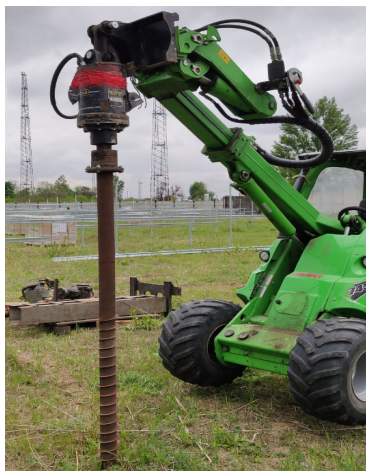
Рис. 2. Процес влаштування багатовиткової палі.
