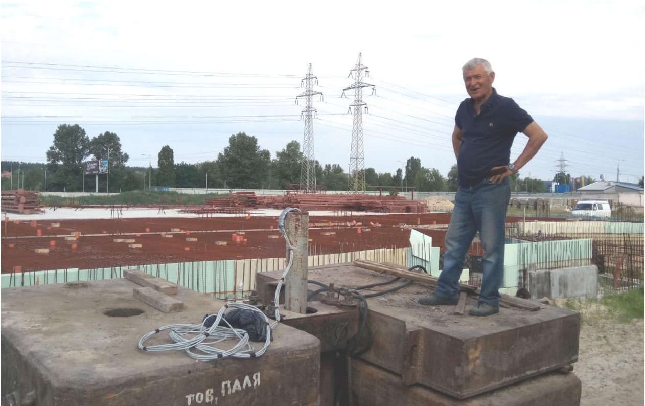
Рис.12. Міжнародні польові дослідження «Pile-test-2019». Підготовка до випробування паль. Fig.12. International field research «Pile-test-2019». Preparation for pile testing.
