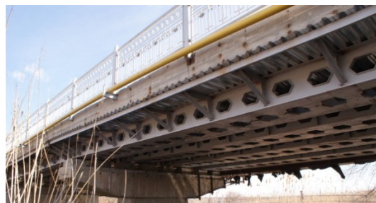
Рис.5. Загальний вигляд прогонової будови (вид знизу).
