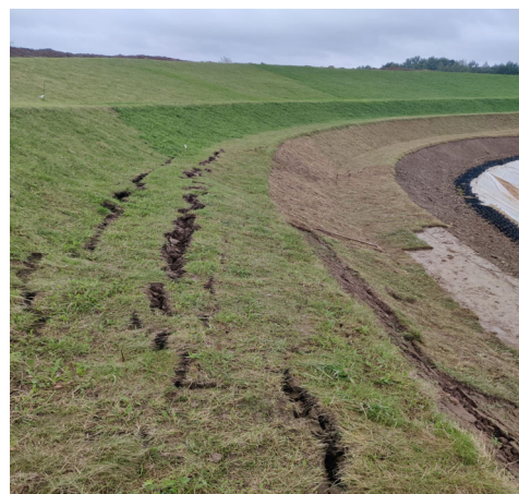
Рис. 4. Початок зсуву після плануванні 3-х сходинок через 3 місяці.
