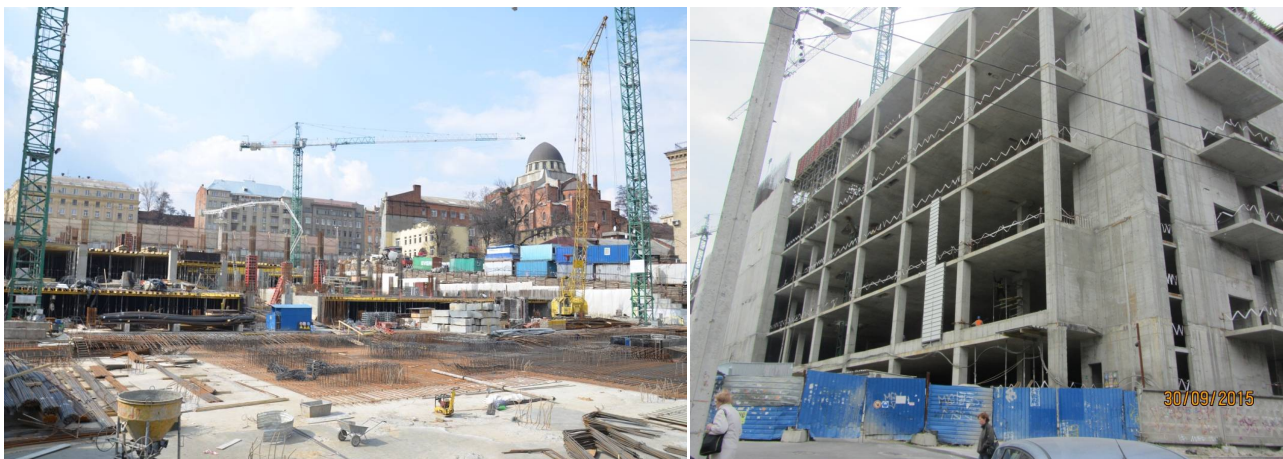
Рис.1. Загальні види будівельного об'єкту (2013-2015 рр.).
