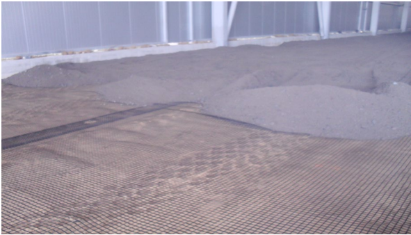
Рис.15. Влаштування додаткових шарів основи під плитну частину, укладання георешітки.
