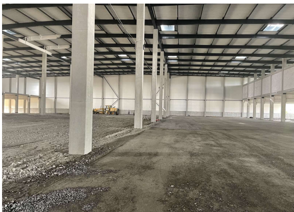
Рис.6. Приклад влаштованої основи під промислову підлогу.
