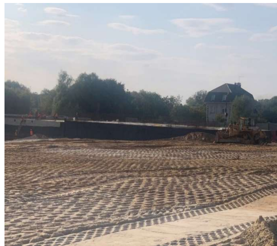
Рис.3. Нівелювання площі майданчика. Fig.3. Leveling of the site area.
