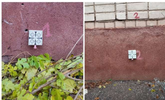
Рис.5. Стінні репери, встановлені у фундаментах споруди.
