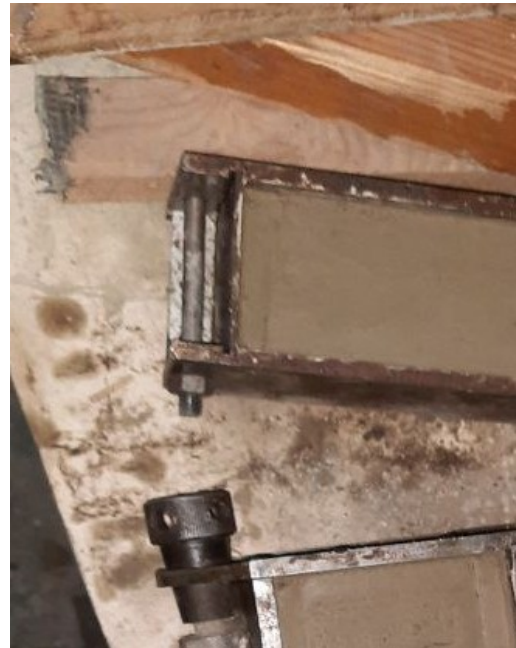
Рис. 2 – Процес виготовлення та укладання Fig. 2 - Manufacturing and installation process
